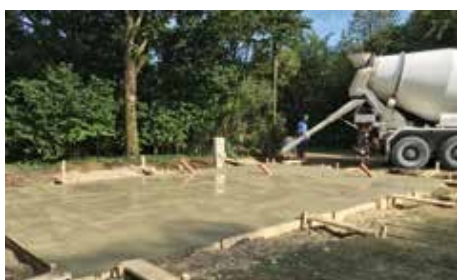
Fundație din beton
