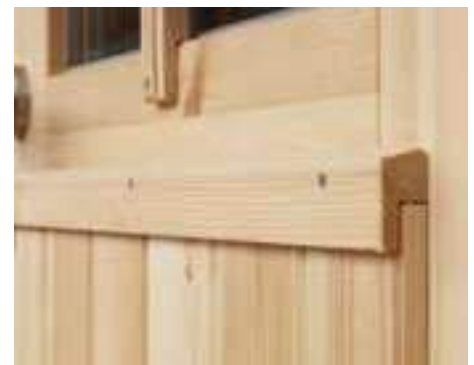
Panoul de ușă cu bandă de acoperire
