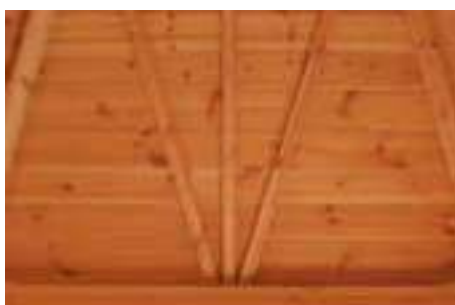
Vedere interioară a elementelor acoperișului
