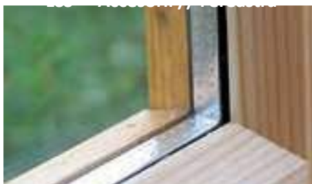
Geamuri termoizolante pentru protecția împotriva frigului, cu o grosime de 28 mm la casele Tanja,
