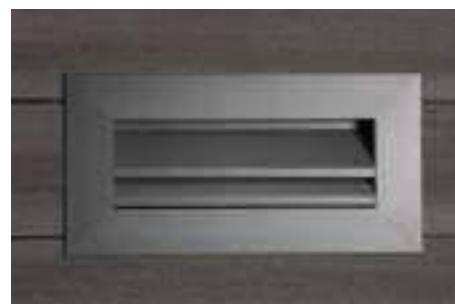
2 elemente de ventilație din aluminiu în peretele
