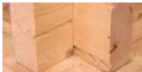
Îmbinare de colț Planșă de 70 mm
