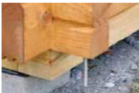
Tije filetate de la grosimea peretelui de 44 mm
