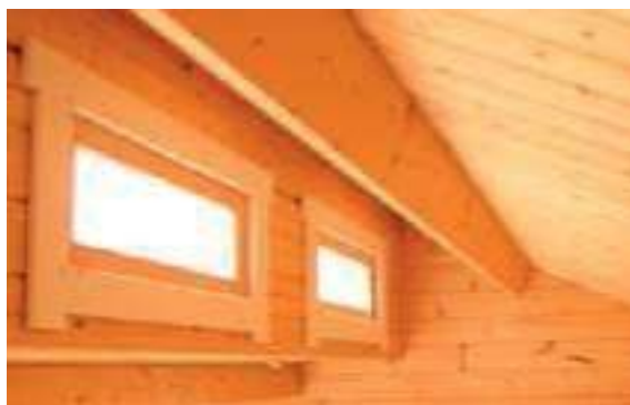
Lina 4031 | Vedere interioară acoperiş şi ferestre
