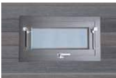
Deschiderea ferestrei din interior, fără instalare ulterioară
