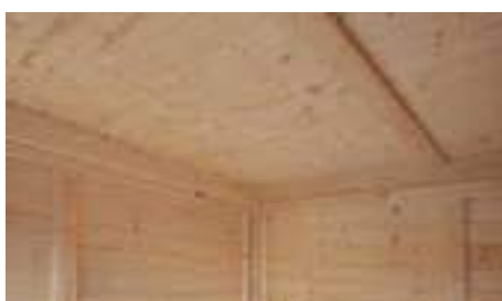
Elemente de acoperiș izolate
