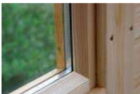
Ferestre din lemn lipit cu geamuri isoglazurate
