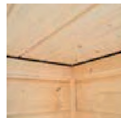
Elemente de acoperiș izolate
